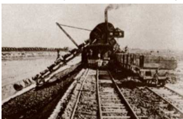
蒸気掘削機による機械掘削の様子
