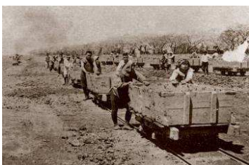
人力掘削の様子（土運搬状況）
